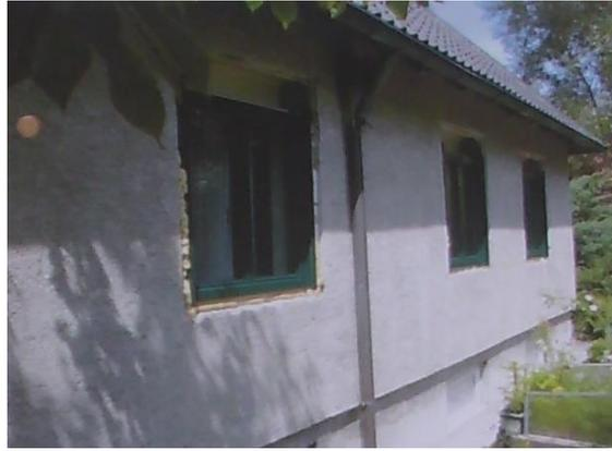
2005: Dämmung der Keller-Sockel (Perimeter) von Nord- Ost- und Westseite des Hauses, ohne Garage. Das charakteristische Merkmal der Perimeterdämmung ist, dass sich die Wärmedämmschicht außerhalb der Grundmauer befindet. Durch diese Maßnahme konnte Herr Keller seine Wärmeverluste maßgeblich verringern.
