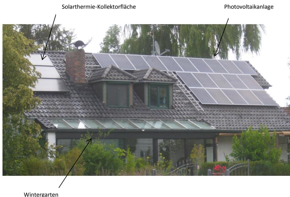
1996: Einbau einer Aufdach-Photovoltaikanlage mit 10 Modulen mit 1,1 kWp und einem Wechselrichter von Siemens/SWM (Volleinspeisung), Zuschuss über BAW, Vergütung: 10-Jahresvertrag mit 2,- DM/1,02 € anschließend. 50,62 Cent/kWh.
