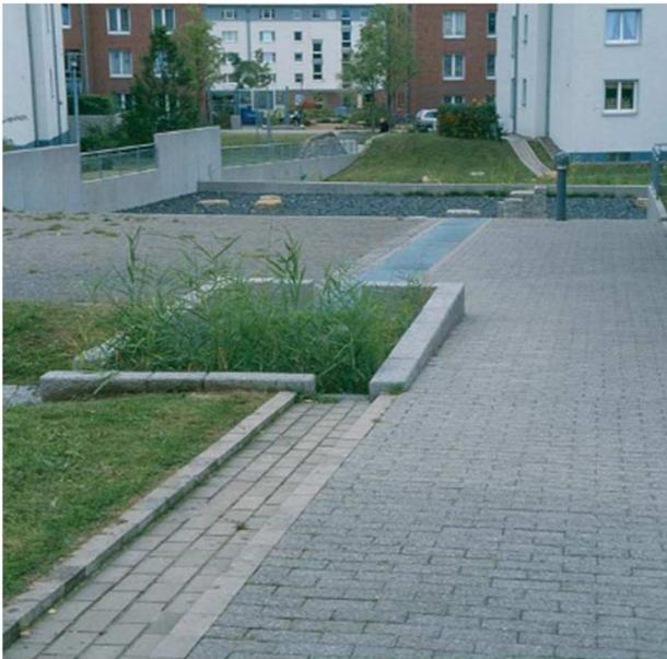
Bild 11: Dezentraler Rückhalt zur Minderung von Abflussspitzen
