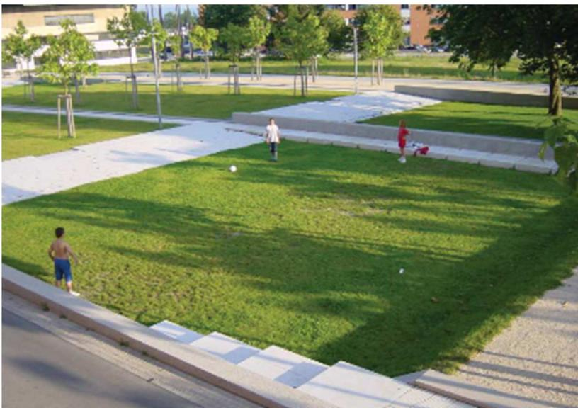
Bild 12: Offene Rückhalteflächen zur Versickerung und Förderung der Verdunstung
